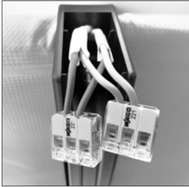
Abb. 46: Profil ohne Beleuchtung
